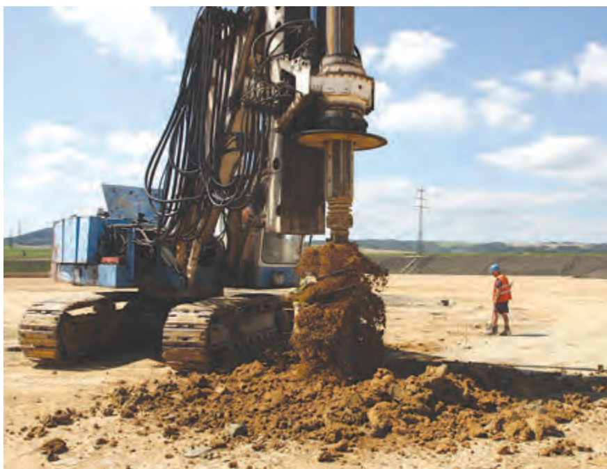
Piloty se vrtaly do hloubky až 12 metrů
