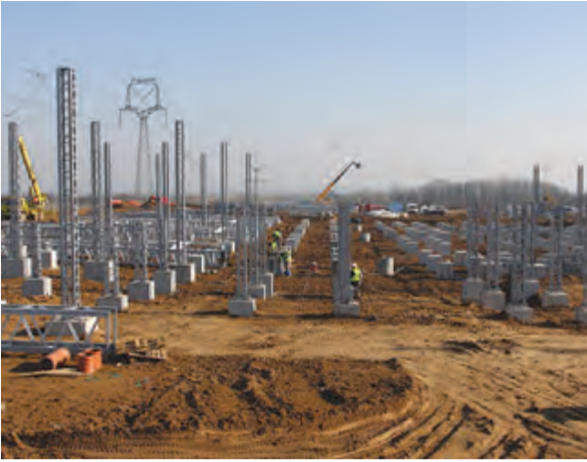
Po vybetonování pilot bylo potřeba realizovat stovky patek
